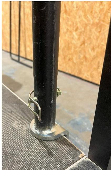
Installer les garde-corps sur les fixations à l'aide des goupilles.
